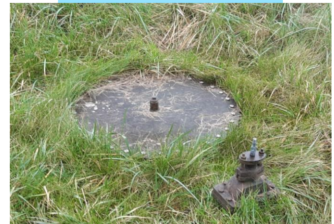
Puits artésien PA2
