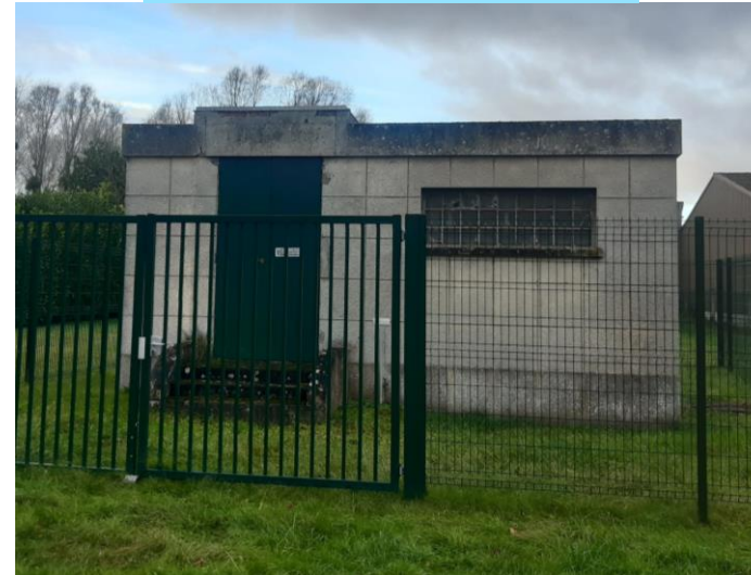
Puits artésien PA1
