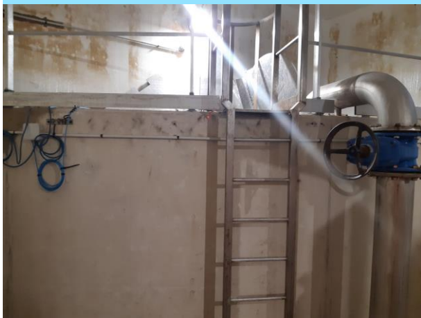
Cuve du réservoir
