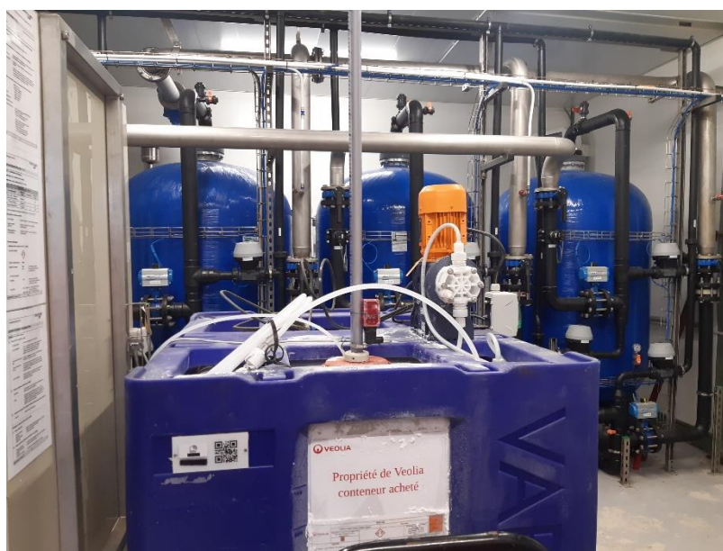
Figure 8 : Station d'adoucissement de l'eau – SMEHE
